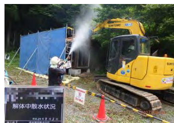
被災家屋等の解体の様子
