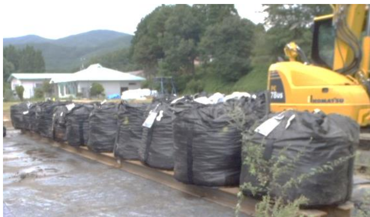
図 2.1.3-6 水切り架台の設置状況の例
