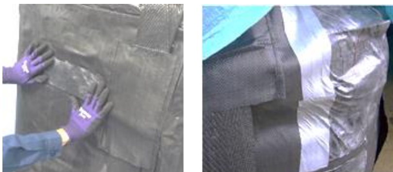
図 2.1.3-4 保管容器の補修
