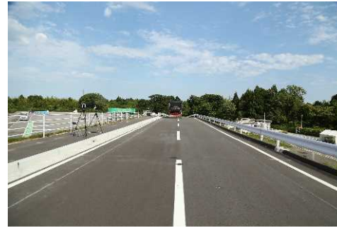
【①総重量約10t走行後】
