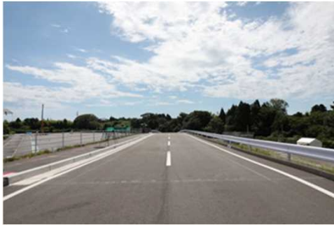
【①総重量約10t走行前】
