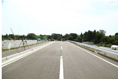
【②総重量約20t走行後】
