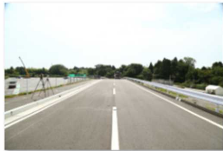
【②総重量約20t走行前】
