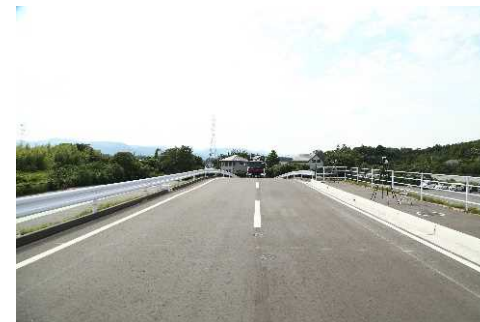
【①総重量約10t走行前】
