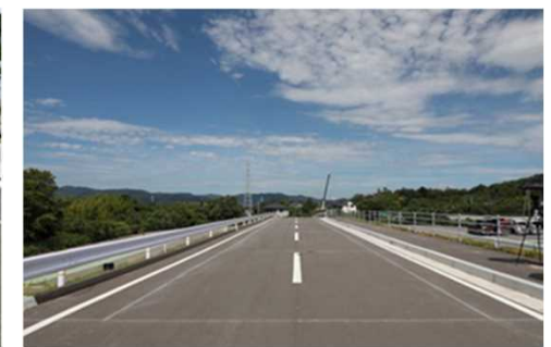
【②総重量約20t走行後】
