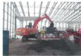
放射能濃度連続分別機への投入
