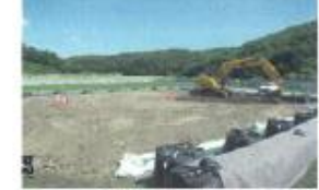
再生資材盛土
