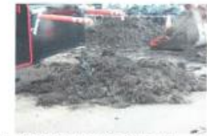
スクリーン不通過の異物（木の根・枝や大きな石等） ⇒盛土材として不適のため除去
