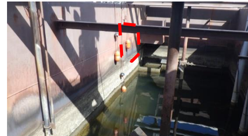
レベルスイッチの交換及び増設状況
