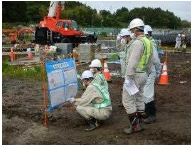
安全パトロールの様子2
