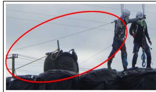
【労働安全コンサルタントによる指摘 ／安全ブロックの適正使用の指導】
