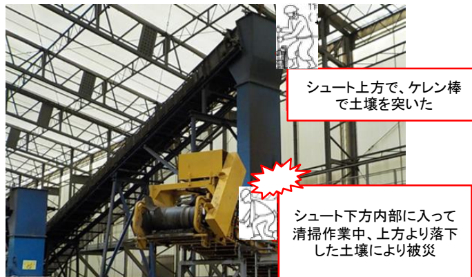
図 事故の発生状況
