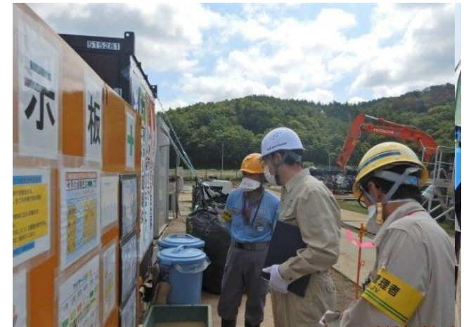
発注者安全点検
