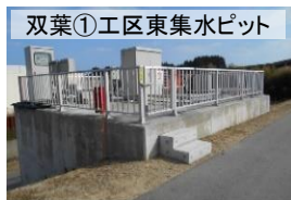
双葉①工区東集水ピット
