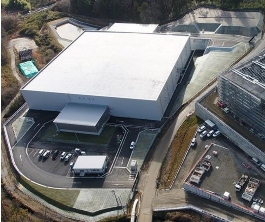
廃棄物貯蔵施設の外観
