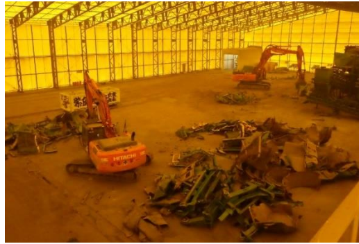
受入・分別施設(解体中)
