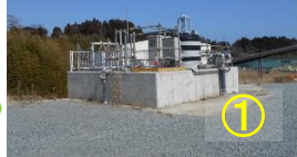
双葉③工区西集水ピット
