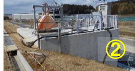
双葉③工区東集水ピット
