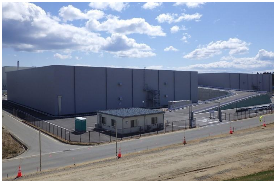
廃棄物貯蔵施設の外観
