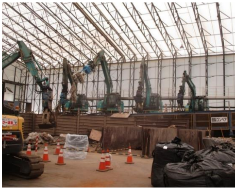
受入・分別施設(稼働中)
