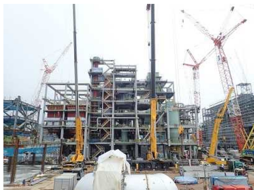
仮設焼却施設：機器据付
