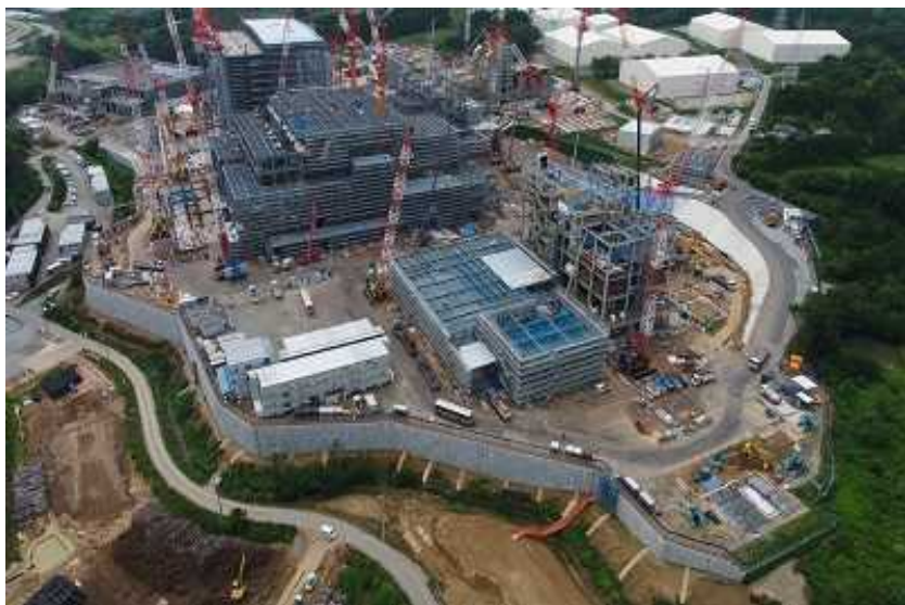
ヤード全景：7月30日現在
