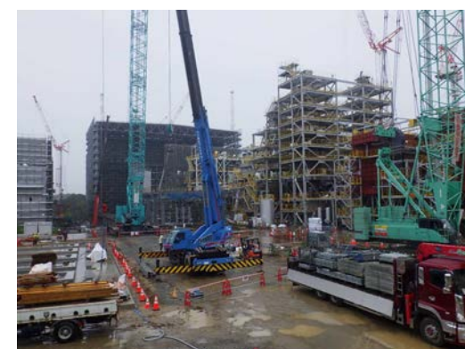
仮設灰処理施設：機器据付
