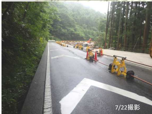
①工区伐採完了
