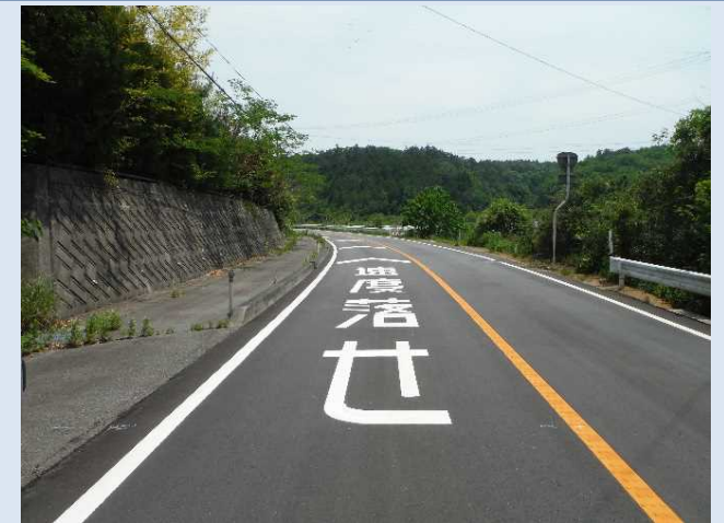
改良工事後の道路の様子(国道288号)
