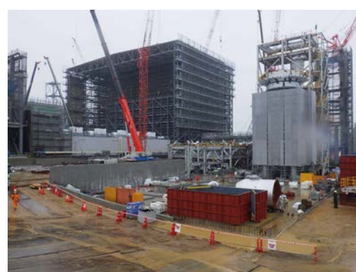
仮設焼却施設：機器据付
