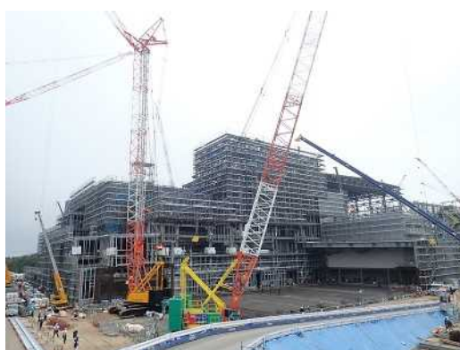
仮設灰処理施設：機器据付
