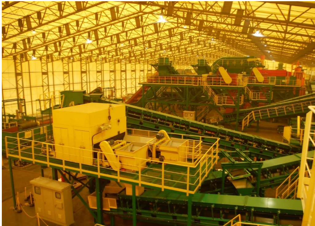
受入・分別施設(受入・分別棟内部)
