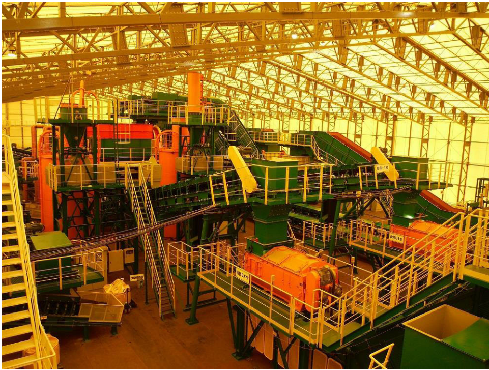
受入・分別施設の建屋内部
