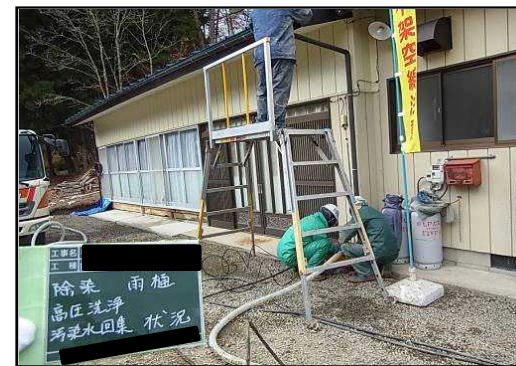
縦樋の高圧水洗浄
