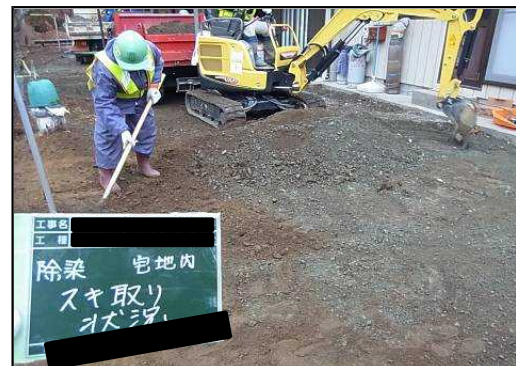
庭碎石の除去・被覆
