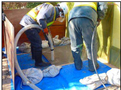
舗装面の高圧水洗浄
